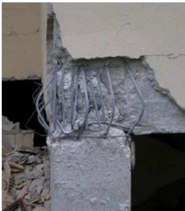
b) crisi per instabilità delle barre.
