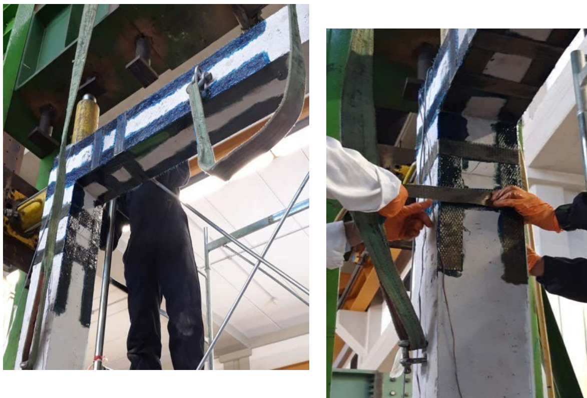
Figura 60 - a) applicazione del secondo strato di matrice sul telaio rinforzato; b) Cerchiatura del pilastro
