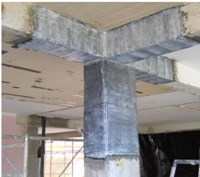
Figura 44 - Rinforzo nodo trave-pilastro con FRP
