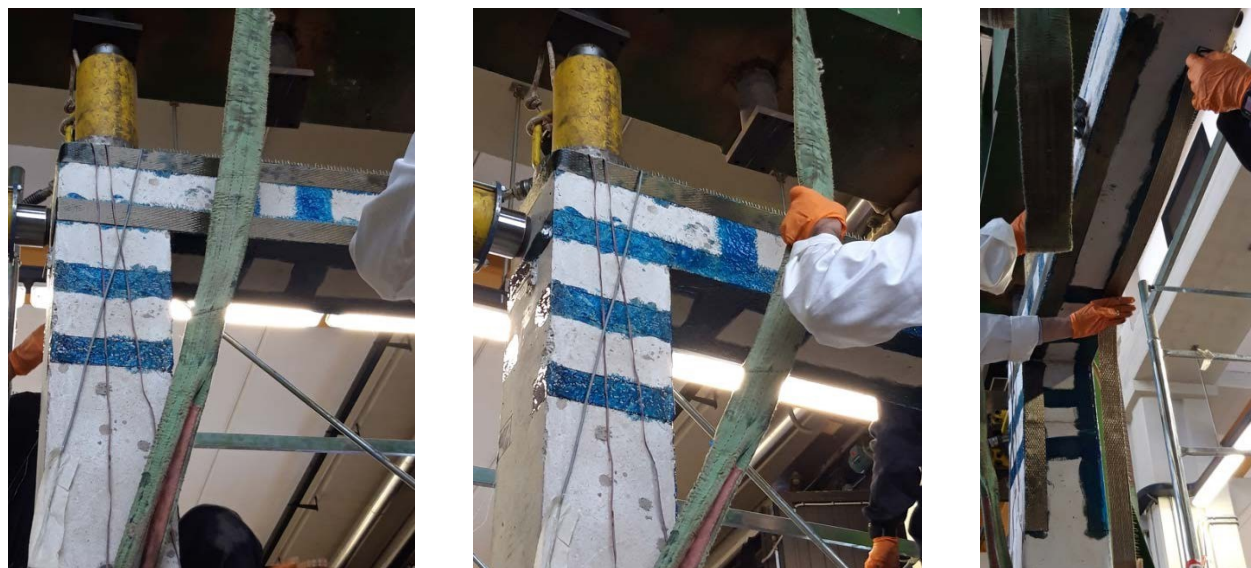
Figura 59 - Applicazione delle fasciature in BFRP
