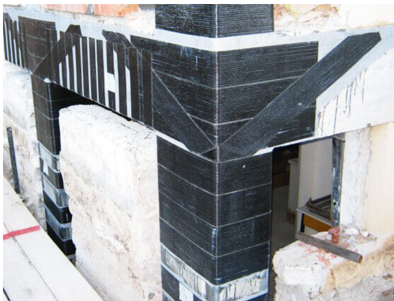
Figura 32 - Confinamento di nodo non confinato mediante FRP
