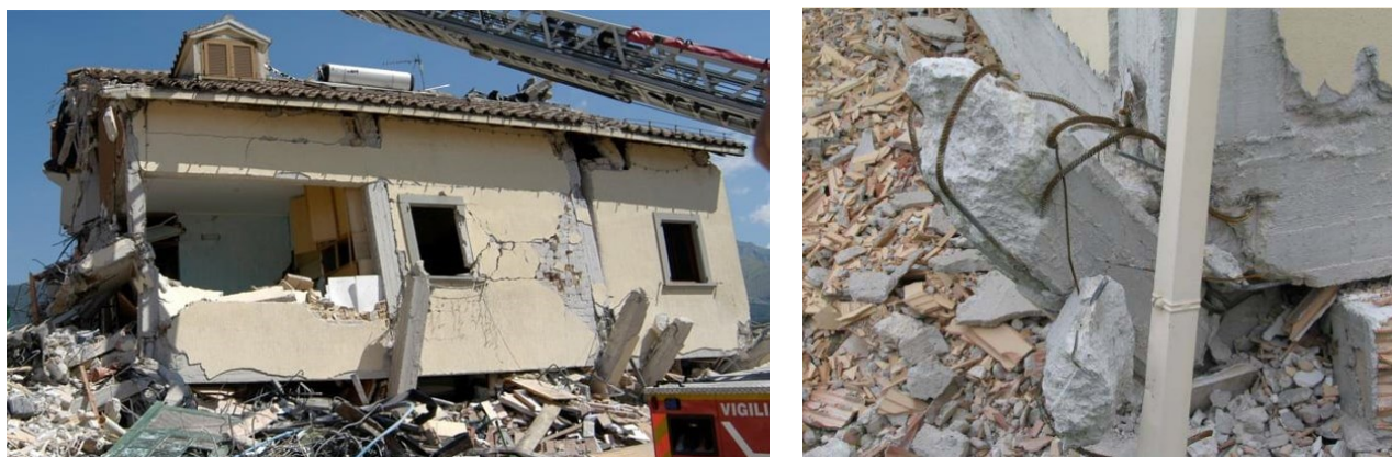
Figura 28 - Amatrice, Hotel Roma - Collasso con sviluppo di piano soffice
