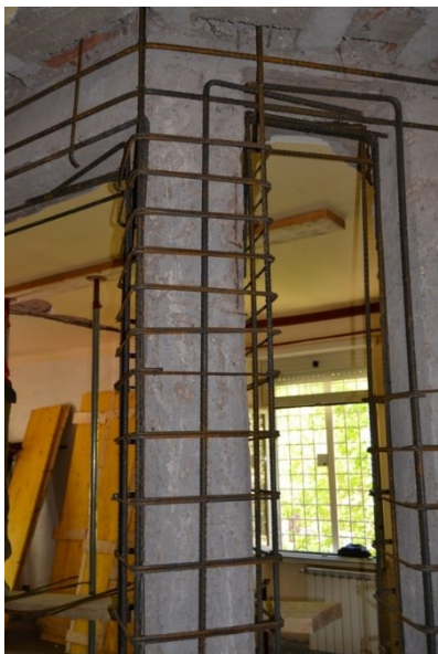
Figura 31 - Incamiciatura pilastro in c.a.
