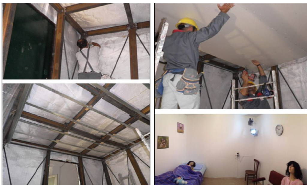
Figura 1.1: Montaggio della cellula antisismica Madis-Room, fasi di montaggio (a sinistra) e fase di rivestimento e completamento (a destra); immagine tratta da: Un nuovo concetto di sicurezza antisismica - Madis-Room, Cellula Antisismica , Pietro Antonio D'Intino.
