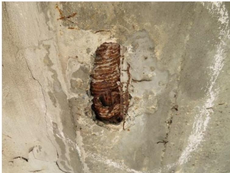
**Figura 1.3** – Degrado dei cavi di un impalcato in c.a.p.
