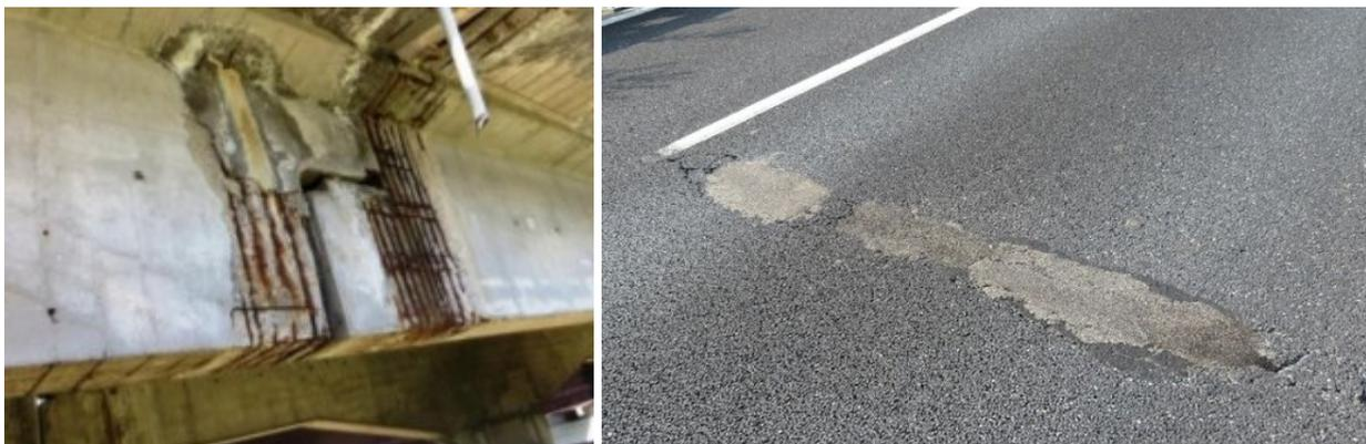
**Figura 1.6** – Degrado sella Gerber (sinistra) e giunto (destra)
