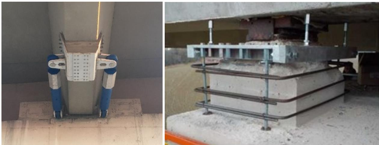
Figura 2.21 – Dissipatori viscosi (Sinistra), isolatori a scorrimento (Destra)
