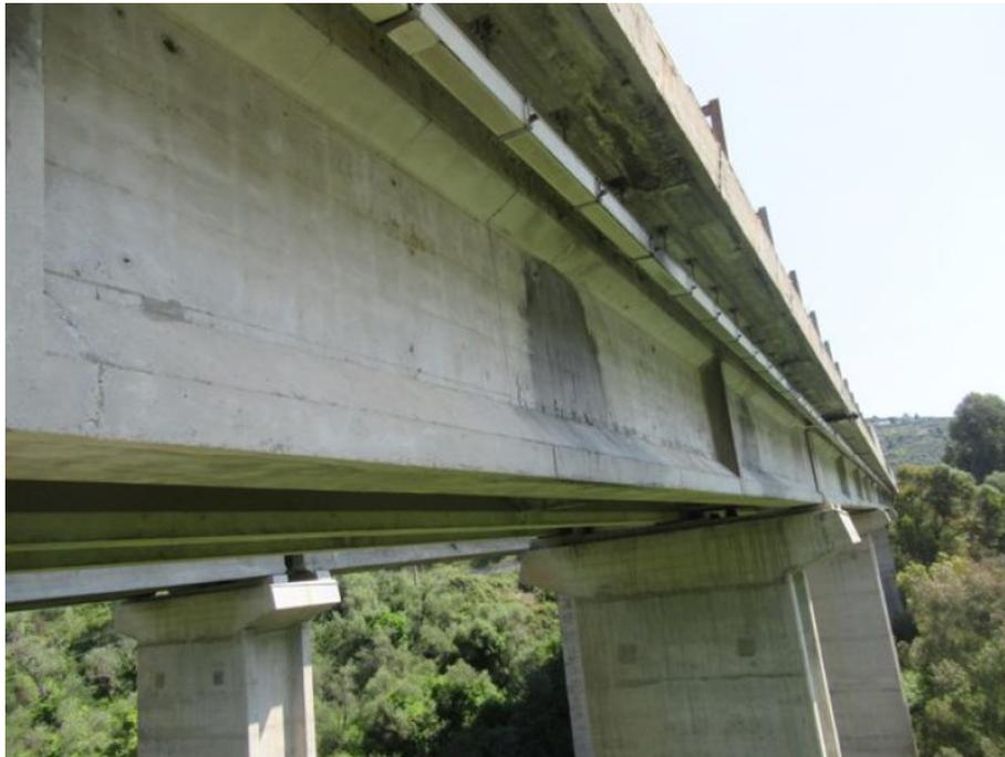
**Figura 1.2** – Degrado di un impalcato in c.a.p.
