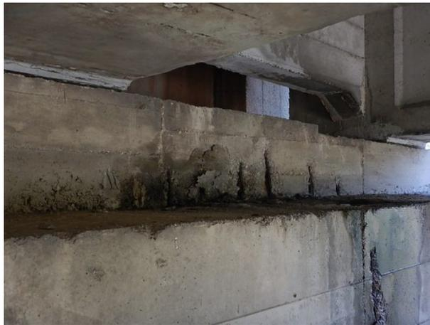
**Figura 1.5** – Degrado calcestruzzo e armature
