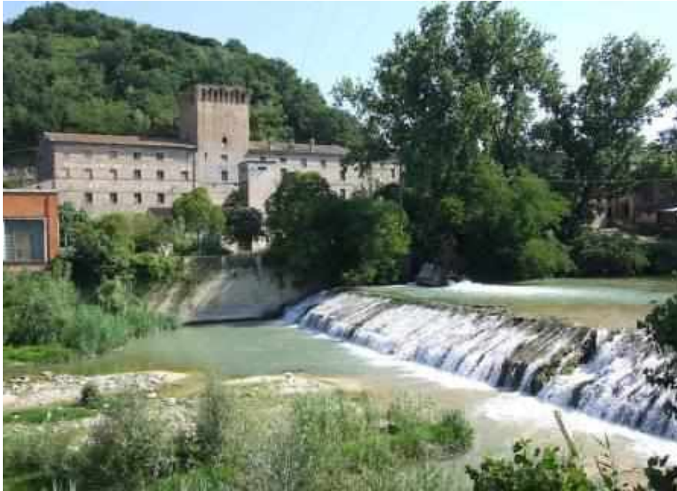
Fig. 15- come si presenta attualmente la torre-osteria.
