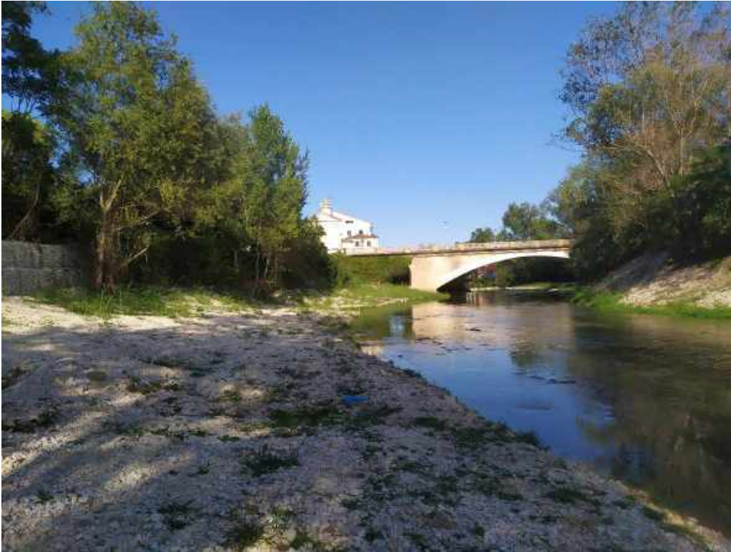
Fig. 36- l'immagine, corrispondente al punto fotografico 9, mostra il tratto di fiume sottoposto a interventi di manutenzione con rimodellamento meccanico, nei pressi del ponte di Passo di Treia.
