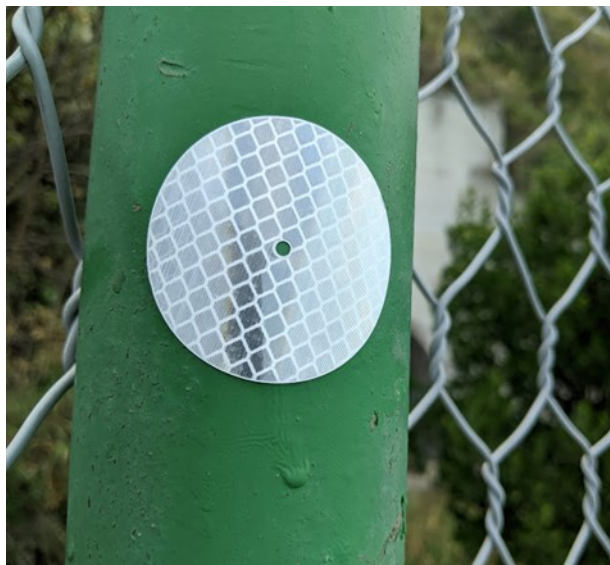
Figura 32 - Dettaglio di un Target posto sulla recinzione al di sopra del canale
