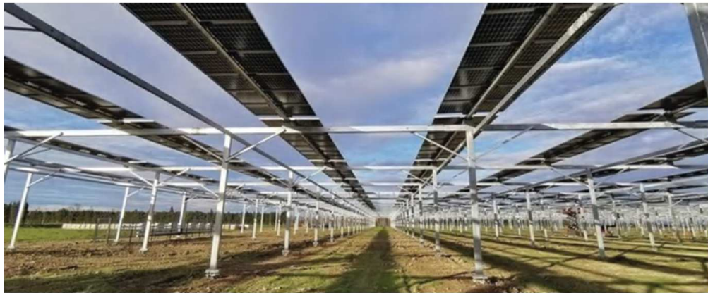
Figura 2.3: Tecnologia del tracking monoassiali
