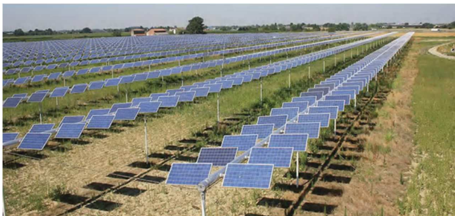
Figura 2.4: Tecnologia del tracking biassiale
