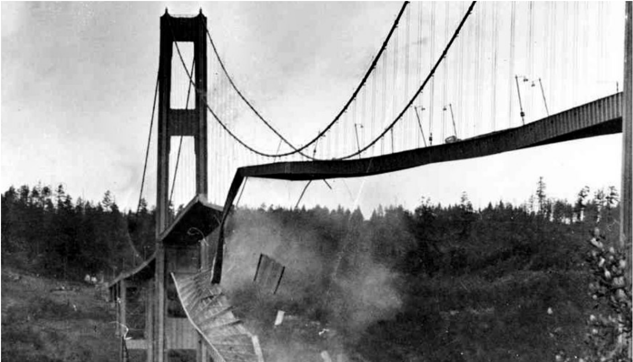
Figura 36: Vortici di Von Karman e Tacoma Bridge ceduto a causa del fenomeno del Flutter aerodinamico causato dal distacco dei vortici di Von Karman ad una frequenza pari a quella di risonanza dei tiranti della struttura
