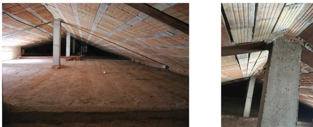
Figura 4.18: A sinistra si notano le travi REP che appoggiano sui pilastri di sezione quadrata 25cmx25cm, mentre a destra un particolare della trave di colmo.
