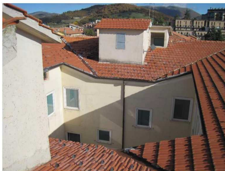
Figura 4.17: Vista del torrino di copertura del vano scala ascensore e di parte della copertura del Fazzini.
