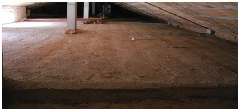
Figura 4.11: particolare delle travi REP estradossate rispetto all'impalcato del sottotetto.
