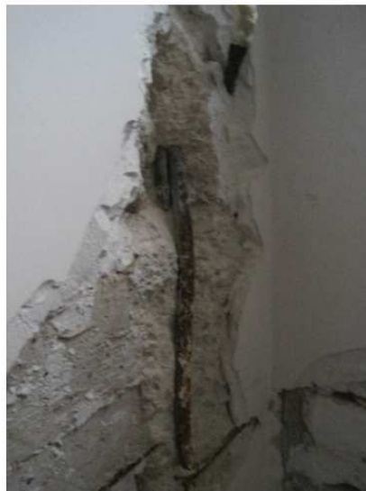
Figura 4.6: Particolare dell'armatura liscia dei pilastri.
