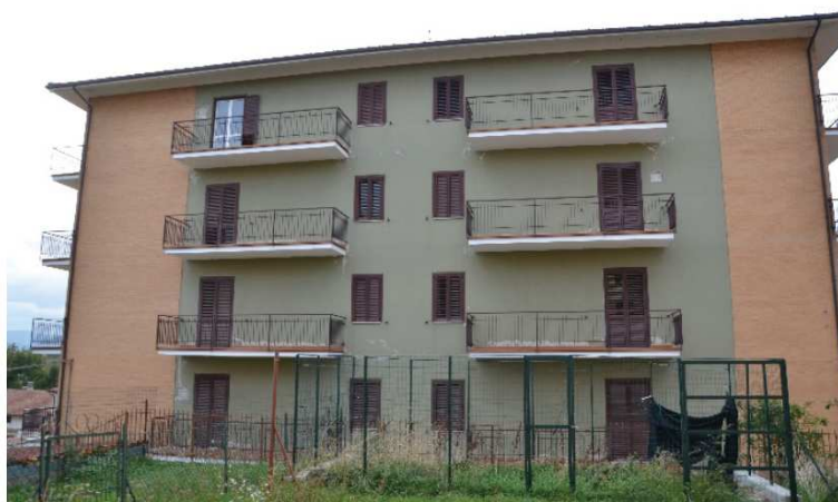
Figura 4.24: Facciata Est: tamponature intonacate al centro e faccia a vista ai lati.
