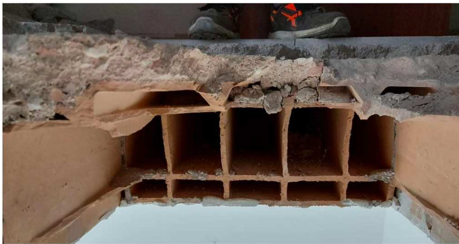
Figura 4.12: Dettaglio della lunettatura delle pignatte del solaio.
