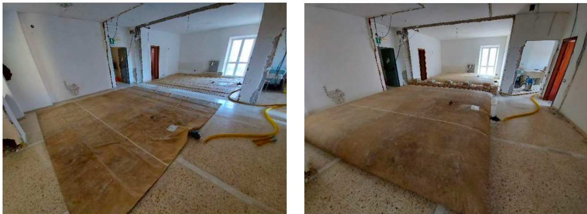
Figura 4.29: Applicazione del carico stabilito mediante materassini riempiti di acqua.
