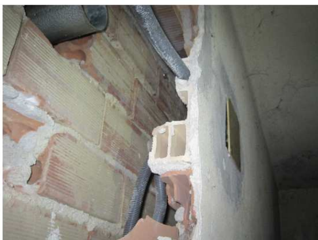
Figura 4.15: Paramento interno del muro contro terra.
