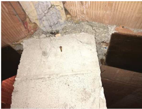
Figura 4.9: Travi REP a sostegno della copertura: i ferri sul corrente inferiore sono \phi 22 .
