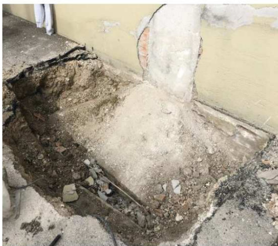
Figura 4.20: Scavo eseguito in corrispondenza di un plinto perimetrale.
