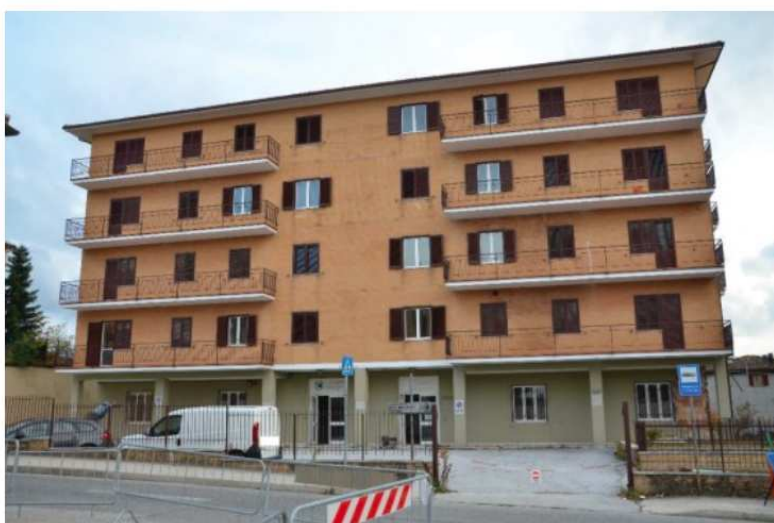
Figura 4.2: Vista della facciata a Nord dell'edificio.
