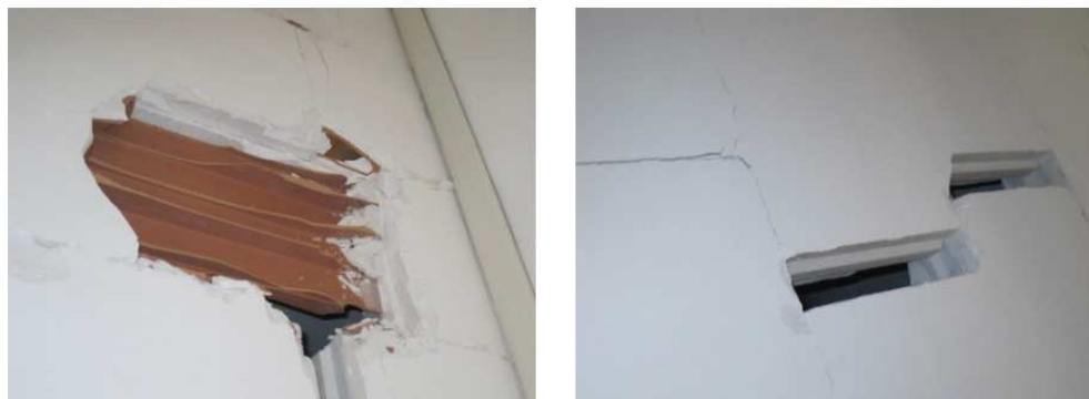
Figura 4.27: Pannelli in latero-gesso con giunti maschio femmina.
