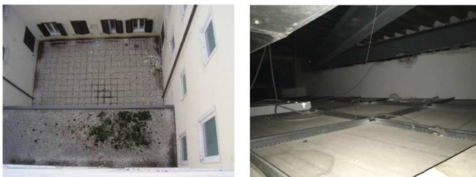
Figura 4.19: Cortile interno con dettaglio della copertura costituita da un solaio misto acciaio-calcestruzzo.
