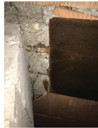
Figura 4.9: Travi REP a sostegno della copertura: i ferri sul corrente inferiore sono \phi 22 .
