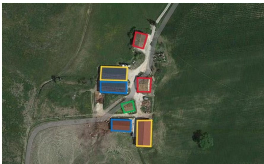
Figura 5-1: Centro aziendale dell'azienda, sita in Domo di Serra San Quirico
