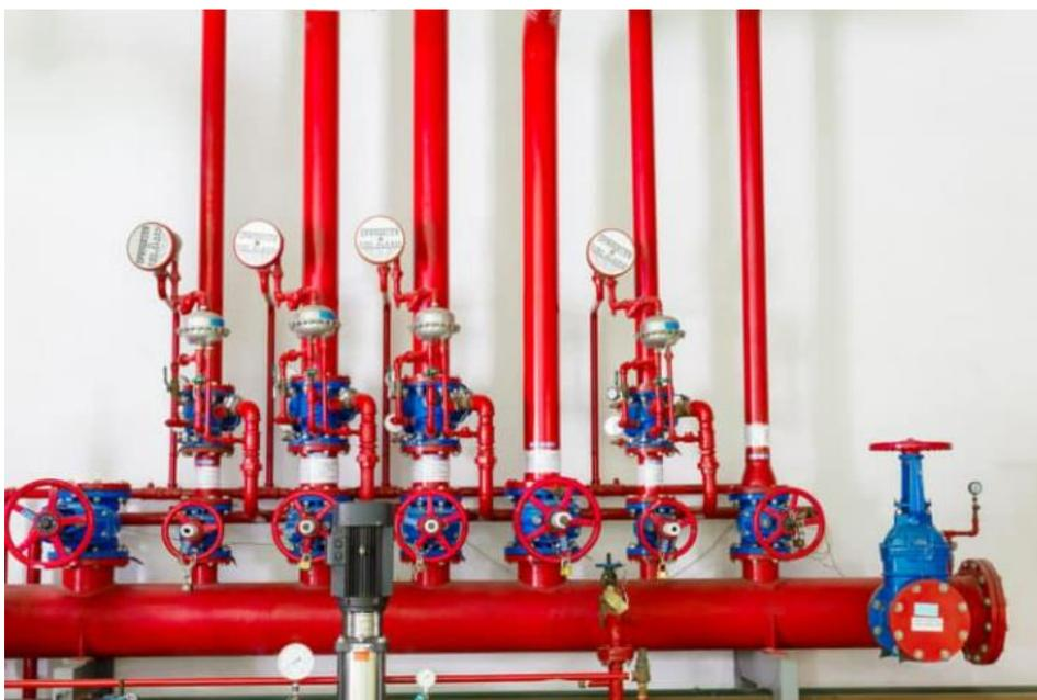
Figura 27 - Foto di impianto sprinkler a secco
