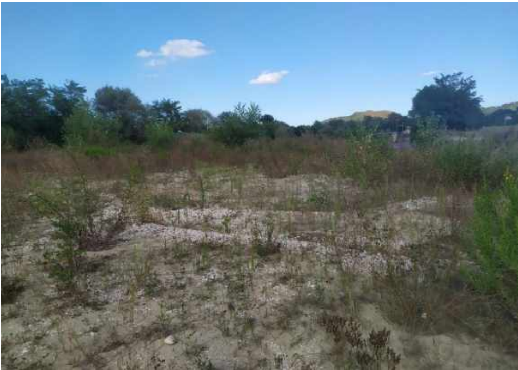
Fig. 33- immagine relativa al punto fotografico 6, tratto di fiume sottoposto ad interventi di manutenzione con rimodellamento meccanico, nei pressi della centrale idroelettrica a monte di Passo di Treia.
