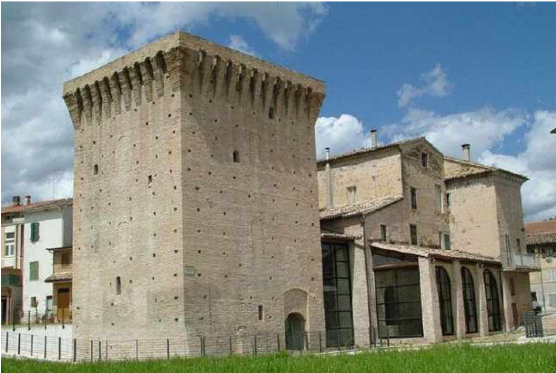
Fig. 14- torre-mulino ad oggi.
