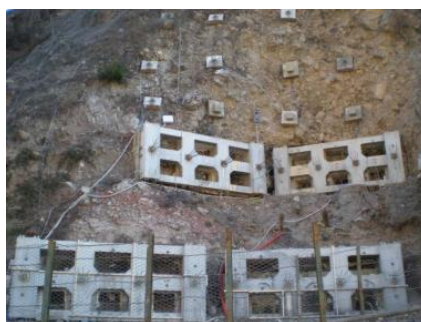
Fig.4 Casino d'Erba (CO), Italia, (2008) Graticci e piastre di ancoraggio
