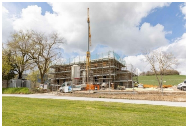
Figura 35. Cantiere in esecuzione.
