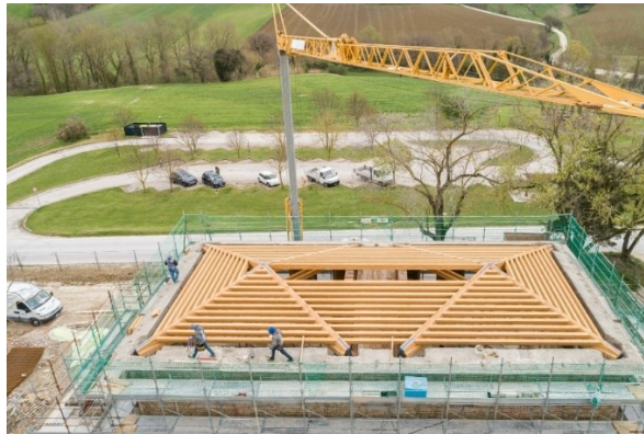
Figura 34. Copertura a padiglione.
