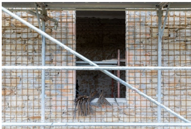
Figura 33. Preparazione intonaco armato.
