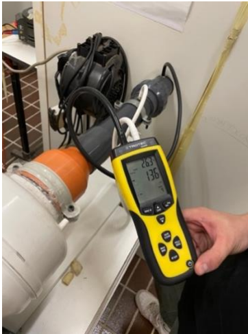
Figura 18. Strumento Trotec TA400.
