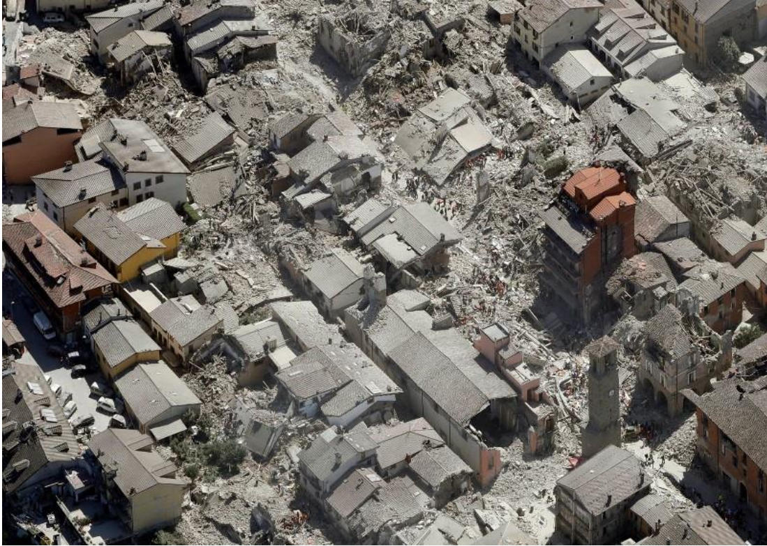
Figura 1.2 - Foto aerea del paese di Amatrice dopo il sisma del 24 agosto 2016
