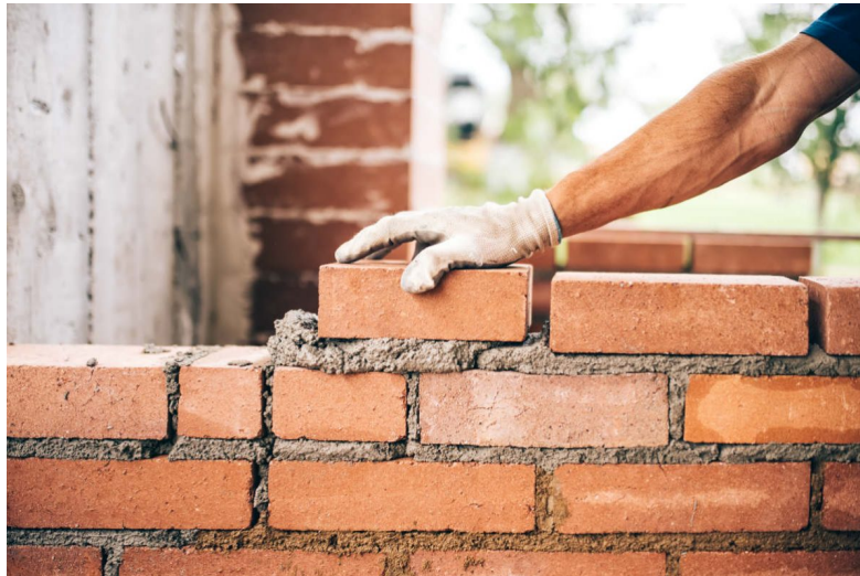
Figura 1.6 Costruzione di un muro usando malta come materiale legante
