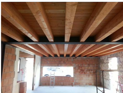
Figura 1.7 - Solaio in Legno
