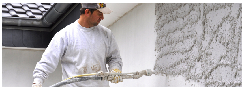
Figura 3.10 - Applicazione dell' Intonaco ARMAMURO
