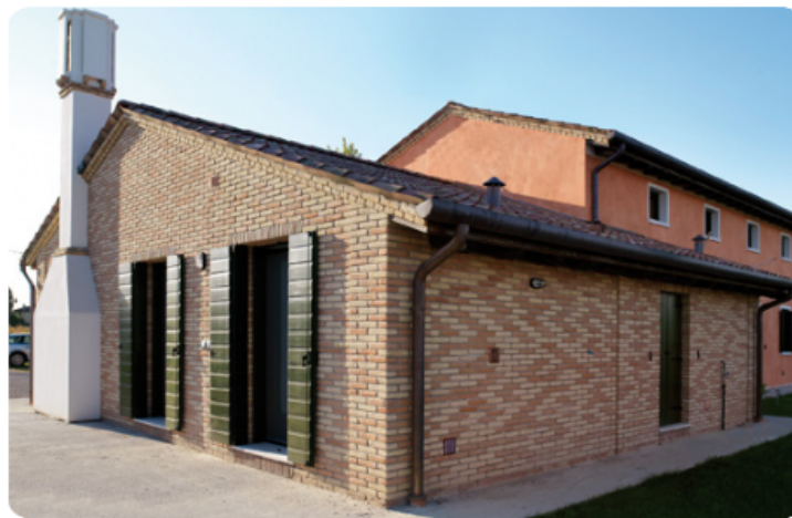
Figura 1.4 - Villetta con Muratura a Faccia Vista
