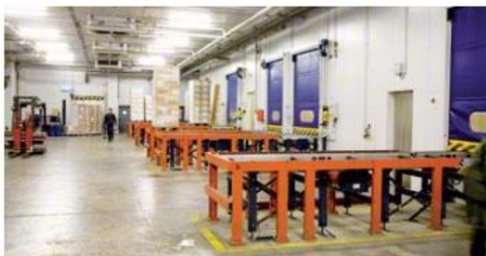
Baia di carico intermedia in cella frigorifera
