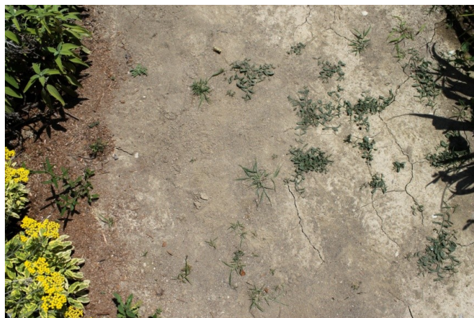
Figura 12: suolo ottenuto con lapillo vulcanico per ammortizzare le cadute
