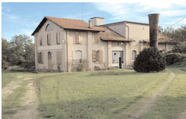
Fig. 2.2 - La centrale idroelettrica di Sambucheto – vista dall'esterno
