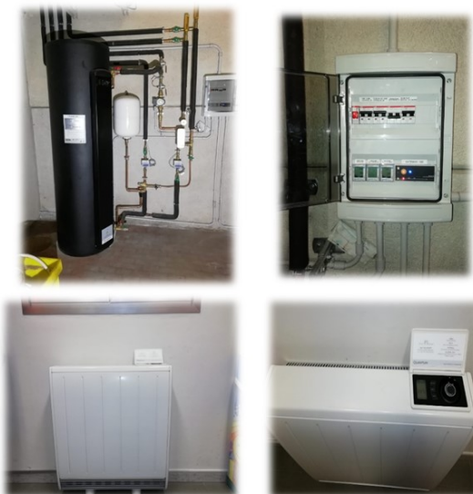
Fig. 6.12 Sistemi di stoccaggio domestico di energia termica attraverso resistenze elettrica con carico controllato installate nel quartiere generale di ASTEA SPA
