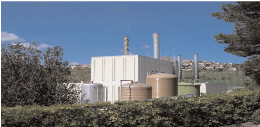
Fig. 2.8 - Vista della centrale di cogenerazione
