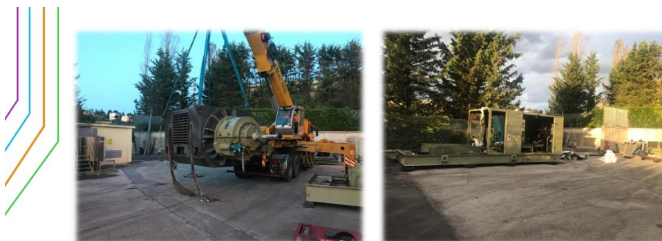
Fig. 6.9 - Foto relative al decommissioning della turbogas
