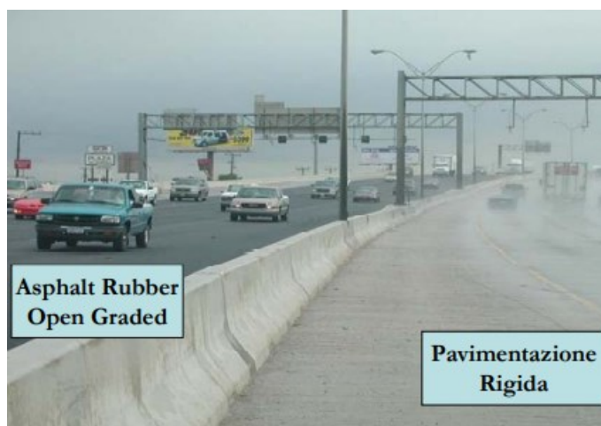
Figura 26: differenza tra le pavimentazioni durante la pioggia
