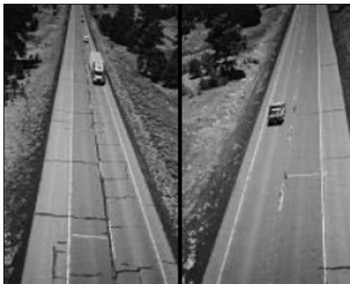
Figura 24: Confronto di due tratti di pavimentazione realizzati con materiali diversi
