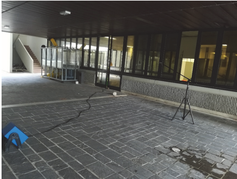
Fig.9: Facciata su cui sono state effettuate le procedure di prova
