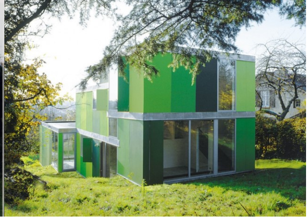
Figura 6 - Lato Nord-Est dell'edificio
