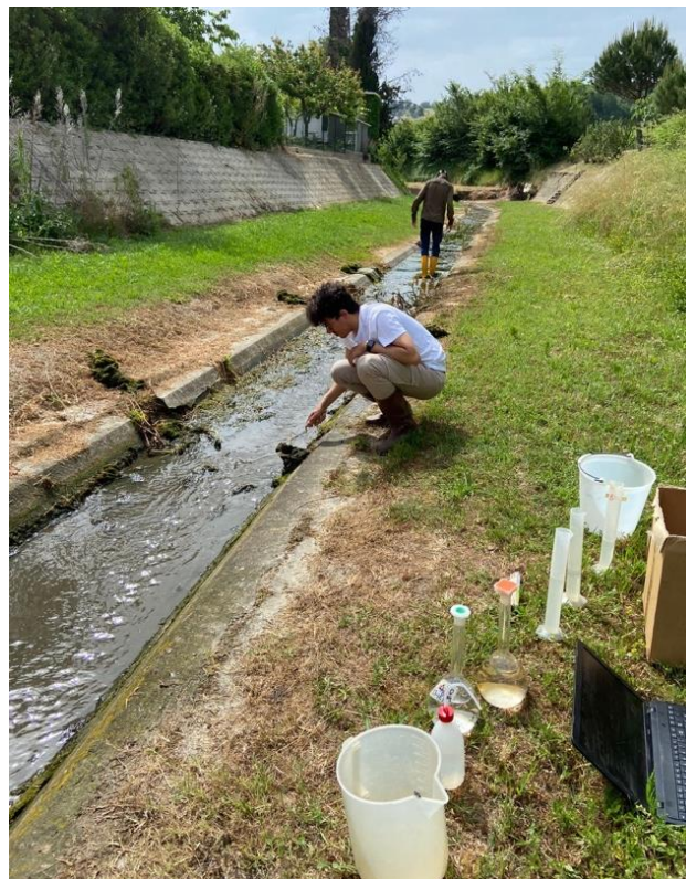
Figura 2.2.1.1 Pulizia del corso d'acqua, rimozione della crescita algale
