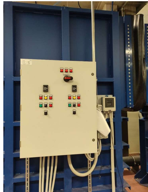
Figure 12-13: Serbatoio di accumulo e pompe-Sistema di controllo per azionamento pompe.
