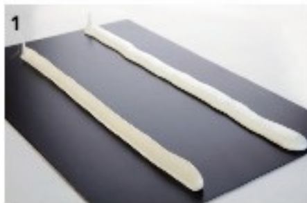
Figura 14 - Applicare un cordolo triangolare di circa 10 cm sul substrato originale precedentemente preparato
