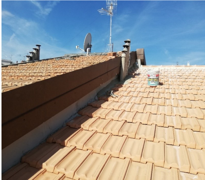
Figura 55: cornice del vano scala completato
