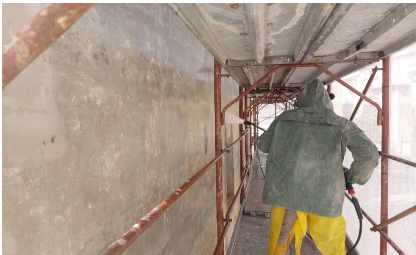
Figura 30: idrolavaggio delle pareti
