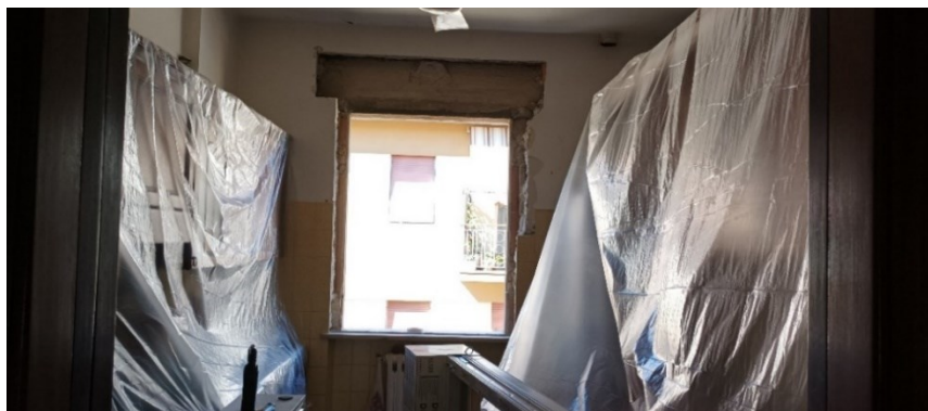
Figura 64: bucatura della finestra senza infisso e cassonetto
