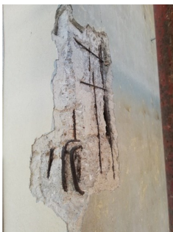
Figura 31: rimozione calcestruzzo ammalorato sui pilastro
