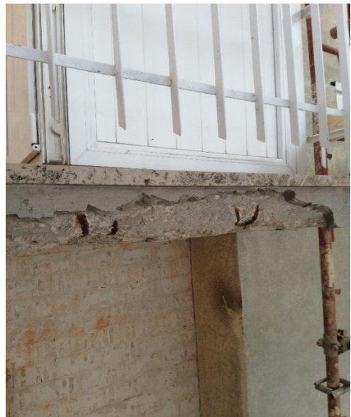
Figura 57: demolizione calcestruzzo sul frontalino del balcone
