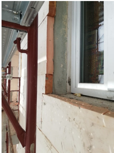
Figura 45: bucatura della finestra prima della posa della termosoglia e della termoimbotte
