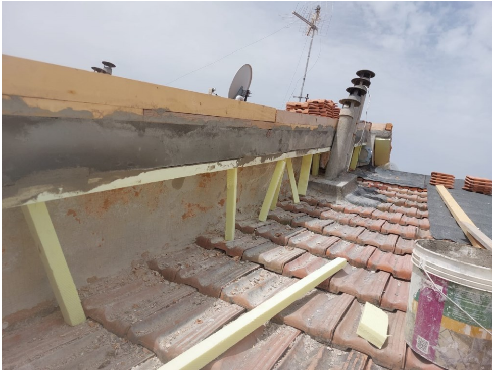
Figura 53: ripristino del calcestruzzo ammalorato sul cornicione della copertura
