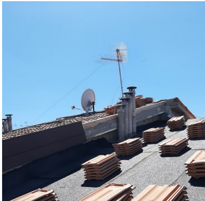
Figura 54: posa della scossalina sul cornicione della copertura del vano scala
