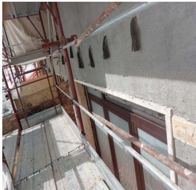
Figura 34: applicazione dei connettore per sistema antiribaltamento RUREGOLD
