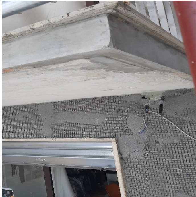
Figura 33: applicazione della rete e della malta inorganica per sistema antiribaltamento RUREGOLD
