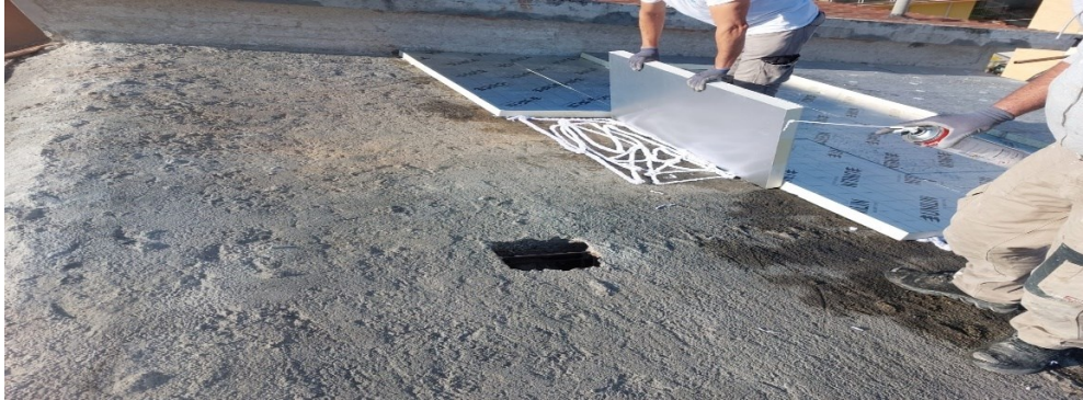
Figura 48: incollaggio del primo pannello per l'isolamento termico di copertura
