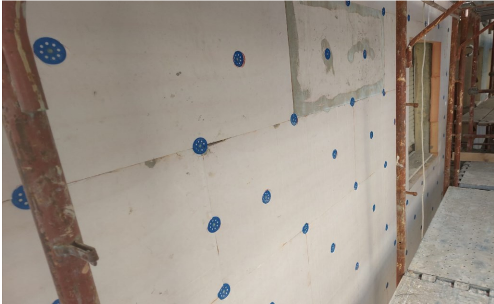
Figura 43: tasselli per il fissaggio del cappotto termico
