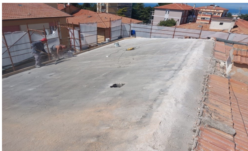
Figura 47: smontaggio del manto di copertura
