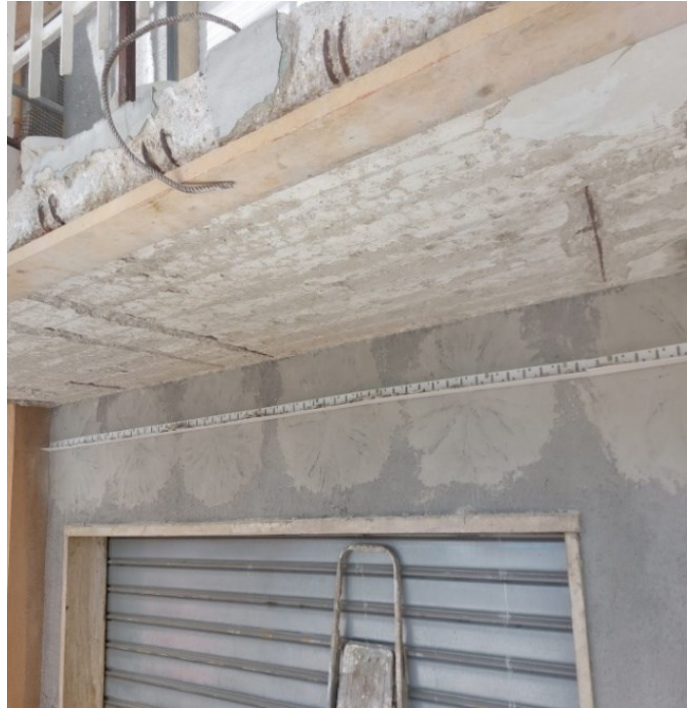
Figura 35: applicazione della malta inorganica sui connettori per sistema antiribaltamento RUREGOLD
