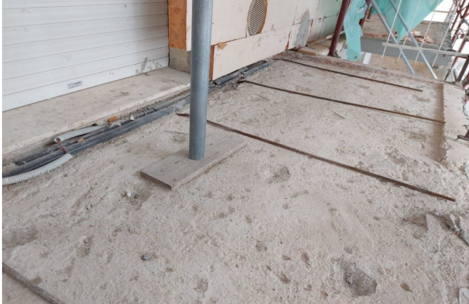
Figura 58: estradosso del balcone demolito
