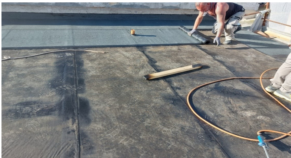
Figura 51: posa degli strati impermeabile sulla copertura
