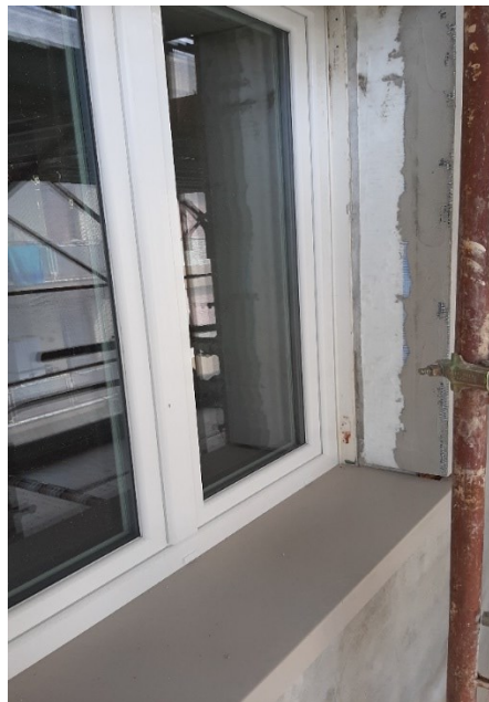
Figura 46: bucatura della finestra dopo la posa della termosoglia e della termoimbotte
