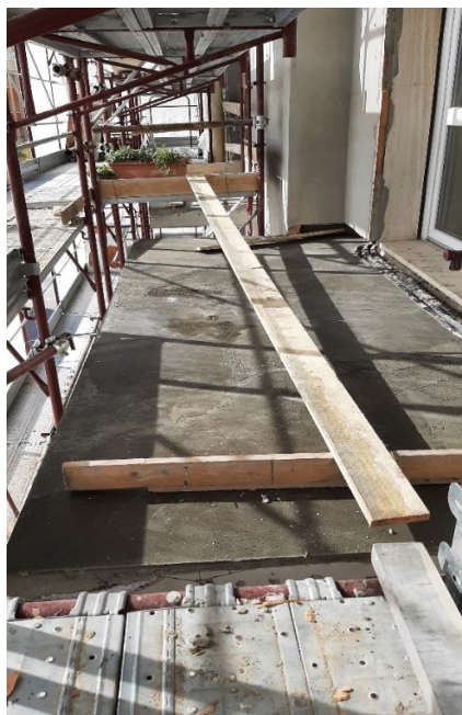
Figura 62: posa del massetto autolivellante sull'estradosso del balcone
