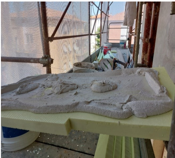
Figura 59: posa del cappotto termico sul sotto balcone
