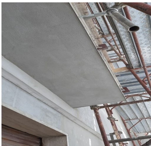
Figura 61: sotto balcone completo di gocciolatoio e tinteggiatura
