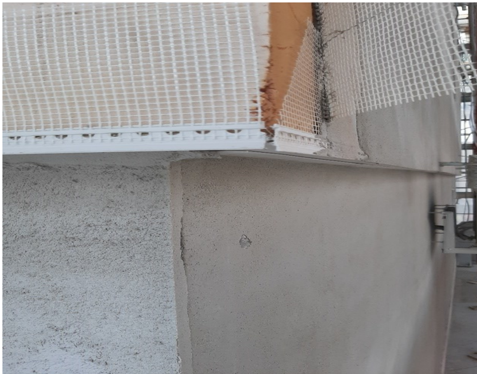
Figura 44: profilo di base per il cappotto termico
