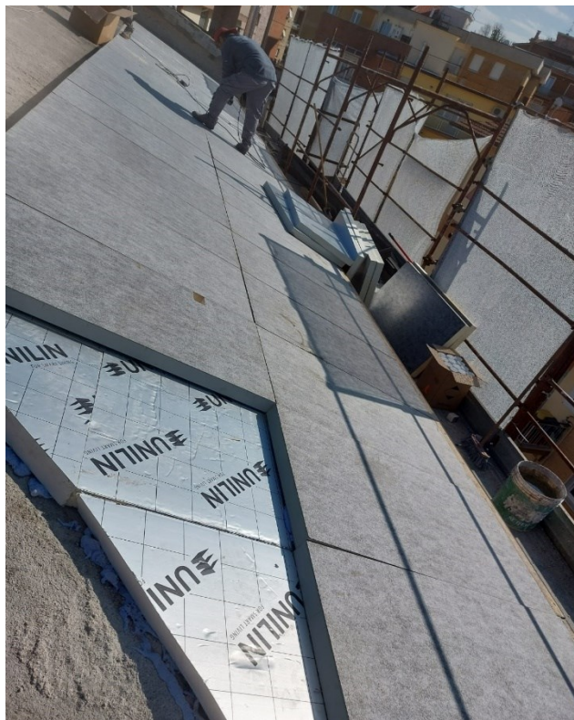
Figura 49: posa del secondo pannello per l'isolamento termico di copertura
