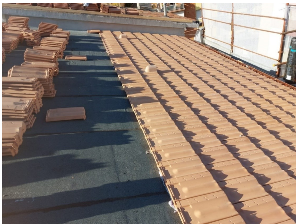
Figura 52: posa delle tegole alla marsigliese sulla copertura
