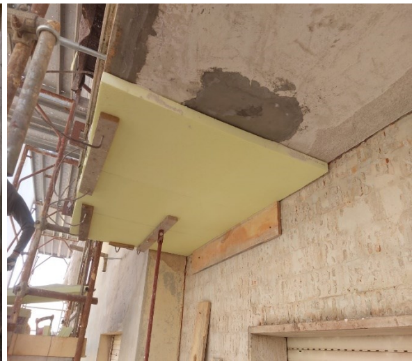
Figura 60: posa del cappotto termico sul sotto balcone
