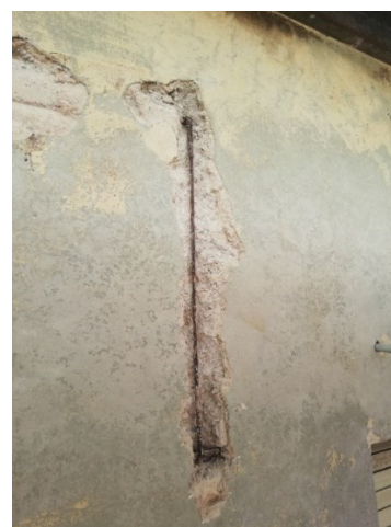
Figura 32: rimozione calcestruzzo ammalorato su trave
