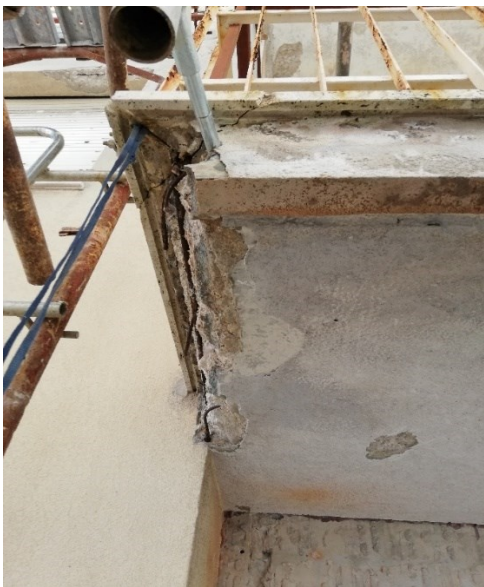
Figura 56: demolizione calcestruzzo sul sotto balcone
