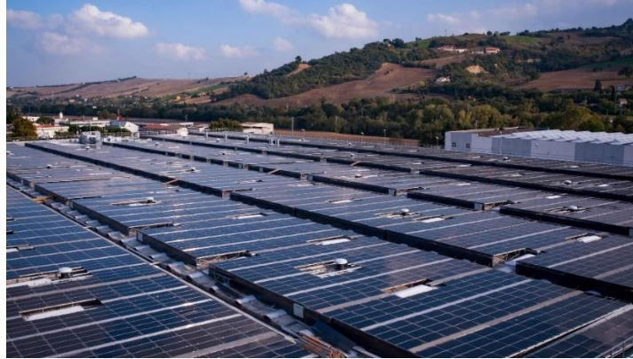
Figura 1.7-Impianto fotovoltaico nella sede Frau a Tolentino
