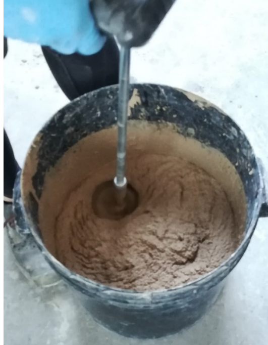
Fig. 11: confezionamento dell'impasto mediante un miscelatore elettrico.
