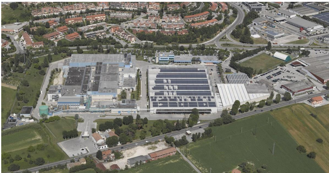
Figura 3.1 – Veduta aerea del sito di Ancona
