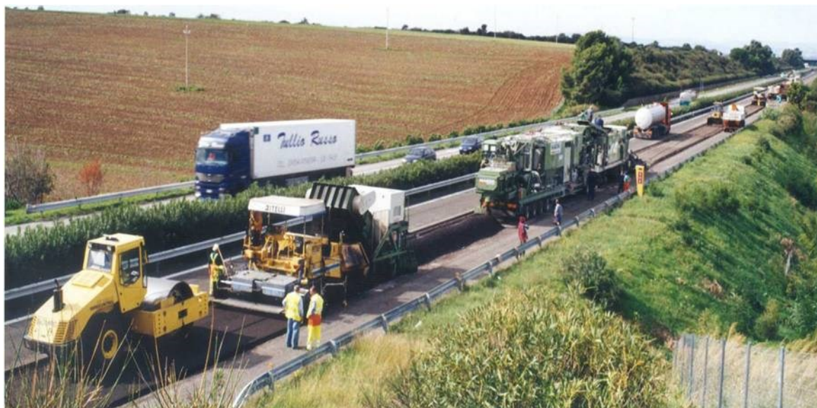
Figura 2.14 – Treno di riciclaggio: mezzi e fasi
