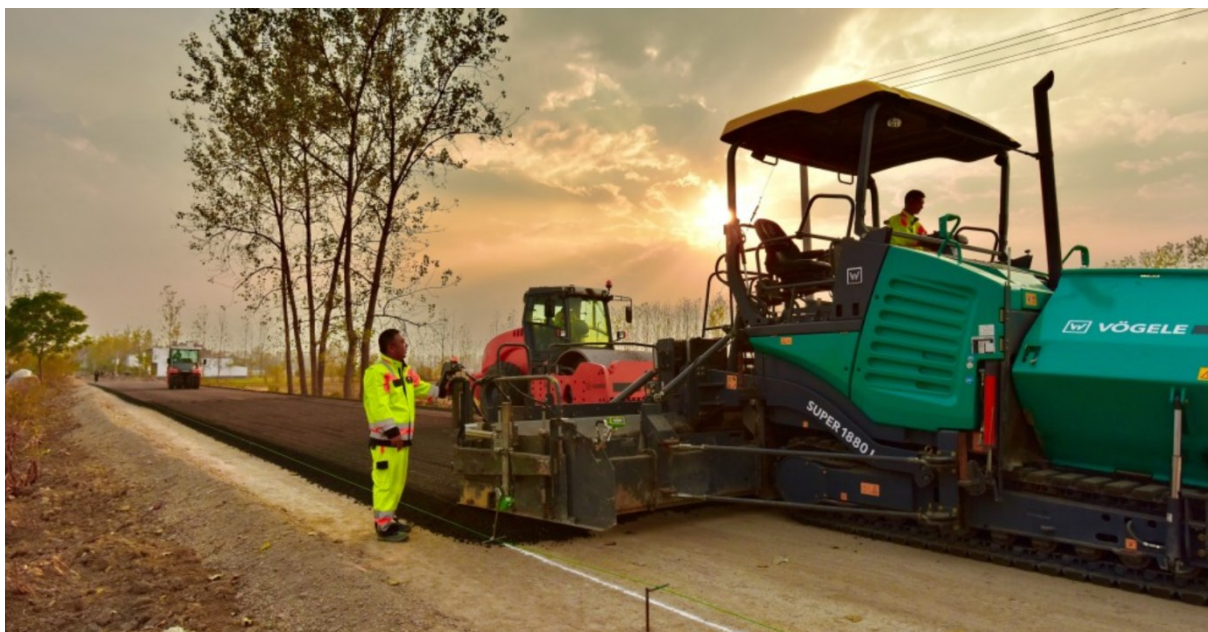
Figura 2.21 – Posa in opera di uno strato di base
