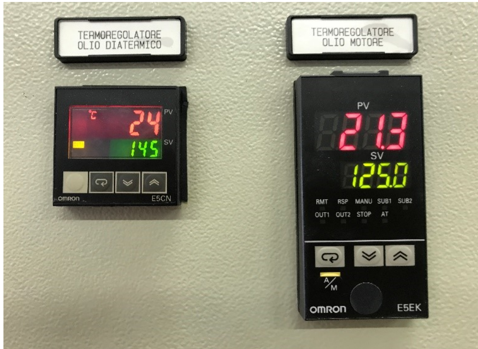
Figura 27: pid di controllo temperatura
