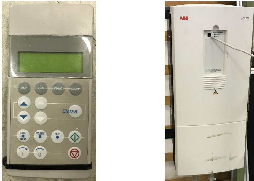
Figura 47: a sinistra il telecomando di controllo giri motore e a destra l'inverter
