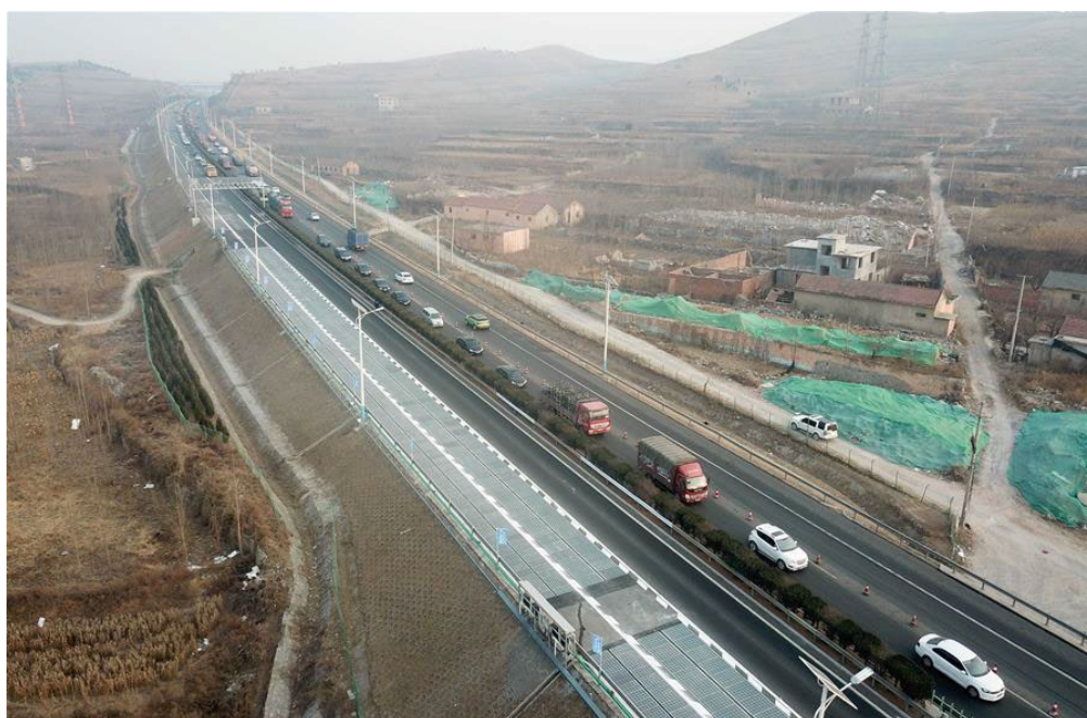
Figura 13 – Autostrada fotovoltaica nella città di Jinan, Cina
