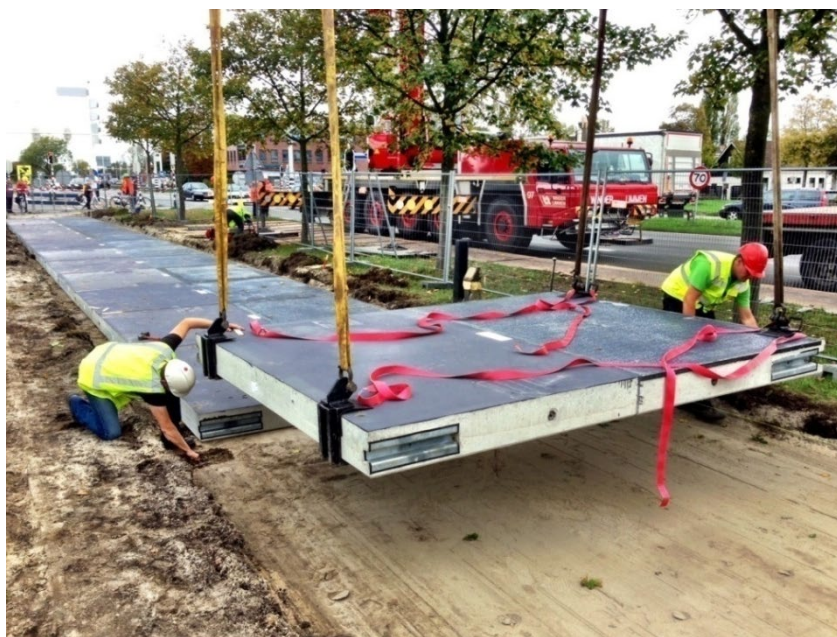
Figura 14 – Pista ciclabile fotovoltaica
