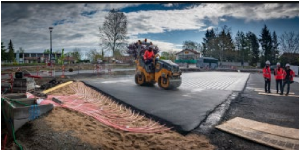
Figura 27 – Applicazione del dispositivo “Power Road” durante i lavori (Feurs)
