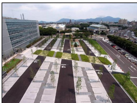
Figura 2.14 Particolare riguardante l'alternanza di pavimentazioni drenanti PLATdesign, NSE Kitakyushu Technology Center, Giappone, Fukuoka, 2011 ( http://landezine.com/index.php/2013/01/nse-kitakyushu-technology-center-by-platdesign/ )
