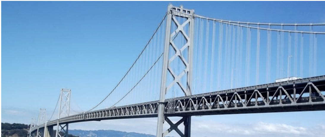
Figura 2.11 Ponte con tiranti in acciaio zincato
