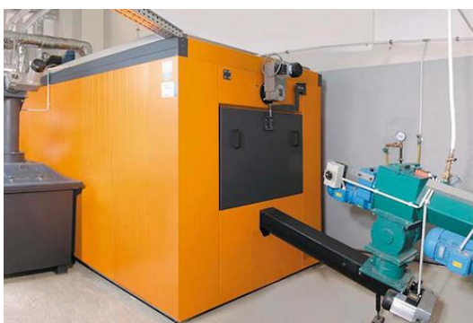
(Figura 2.5) – Caldaia a cippato
