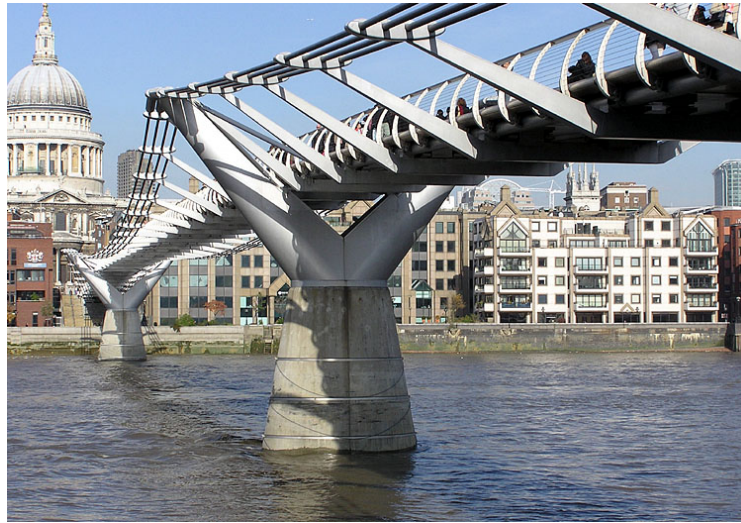
Figura 1.4: Immagine del ponte visto dal lato sud del Tamigi, da [4]
