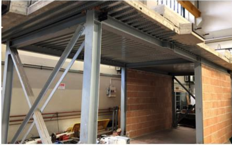
Figura 3.2.2 -Foto telaio tamponato
