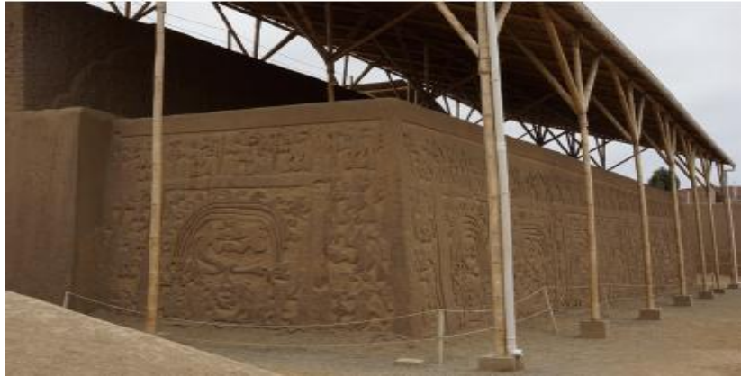
Copertura messa a protezione dei bassorilievi
