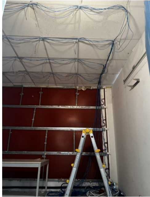
Figura 11: Installazione delle termocoppie
