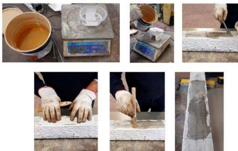
Figura 3.1 – Fasi messa in opera della striscia in GFRP
