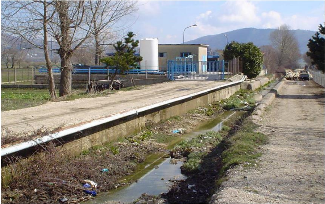
Figura 9: Impianto di depurazione del comune di Volturara Irpina
