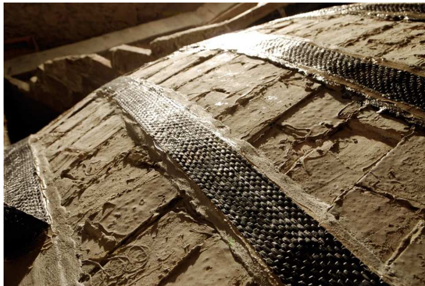
Figura 3.3 – Posa di uno strato di malta atto a regolarizzare la superficie di posa.
