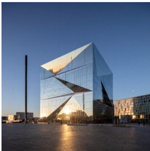
Fig. 1.2 Cube Berlin, Berlino: esempio applicativo di facciate continue in vetro strutturale. Fonte: [1].
