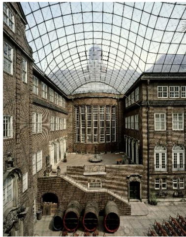
Fig. 1.4 Vista delle volte a botte e della zona di transizione. Fonte: [n].
