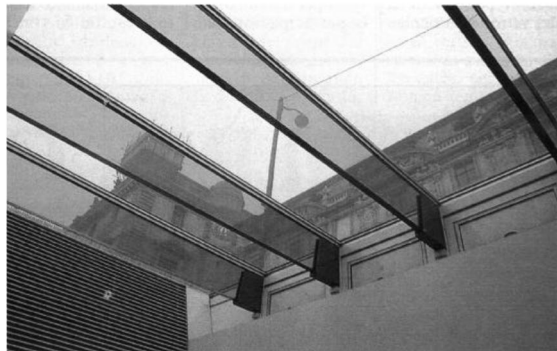
Fig. 1.9 Copertura dei laboratori del Louvre, Parigi. Fonte: [10].
