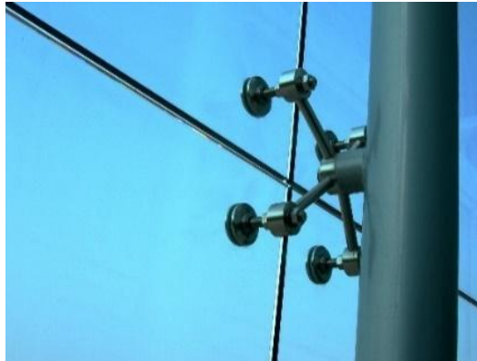
Fig. 1.1 Ancoraggio puntuale di una facciata in vetro strutturale agli angoli di ciascuna lastra. Fonte: [k].
