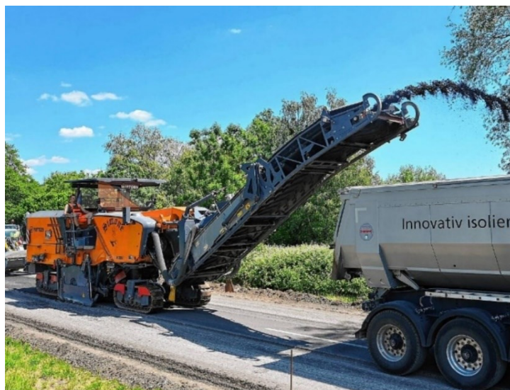
Figura 1.2 – Demolizione con fresatrice
