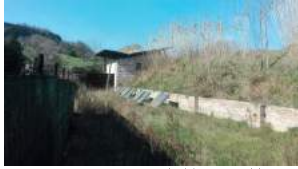
Stato attuale del Deposito del Tempo
