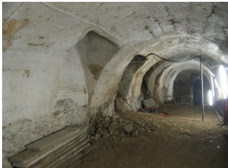
Figura 13. Vista galleria ovest
