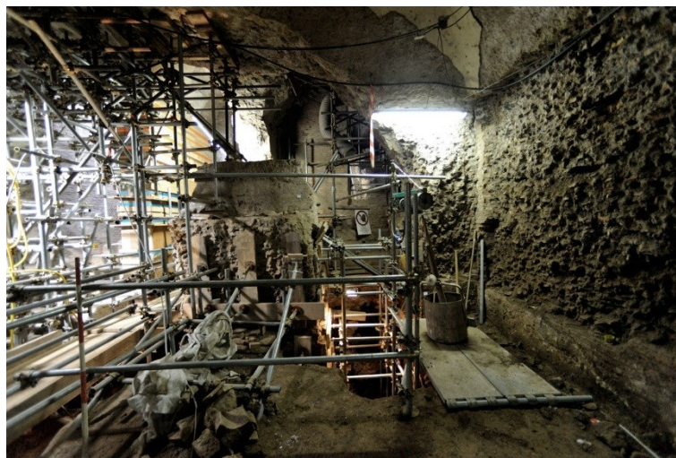
Figura 35. Opere di consolidamento nell'angolo nord-ovest del criptoportico
