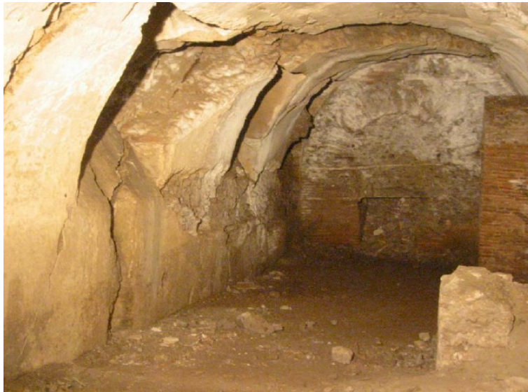
Figura 14. Vista galleria sud
