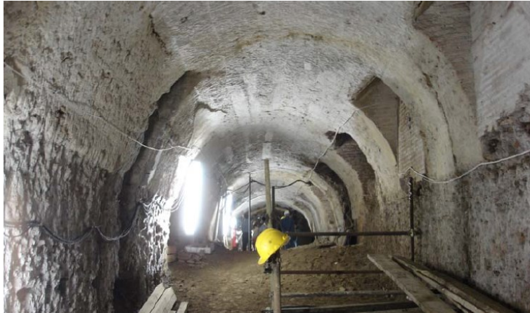
Figura 15. Vista delle bocche di lupo della galleria ovest
