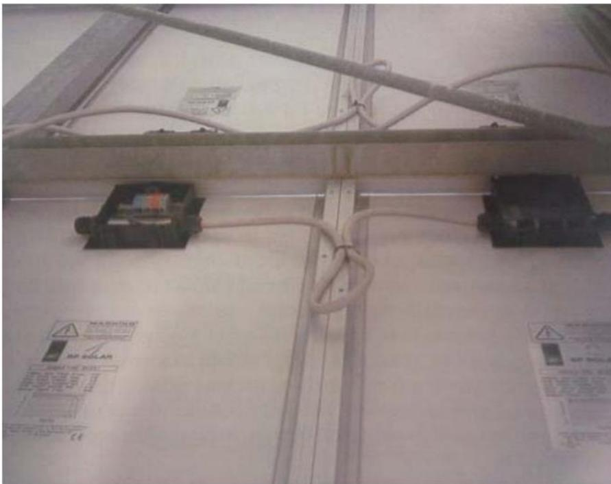
*Figura 11: vista posteriore di una porzione di generatore fotovoltaico costituito da moduli monocristallini*
