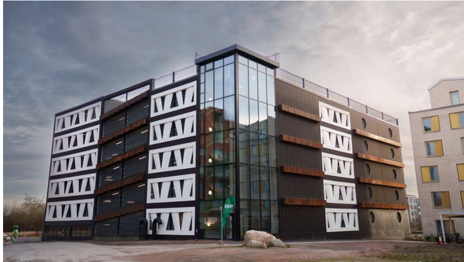
Figura 4.20 Parcheggio multipiano con elementi di facciata non strutturali ricavati dal riciclo delle pale eoliche (Svezia)
