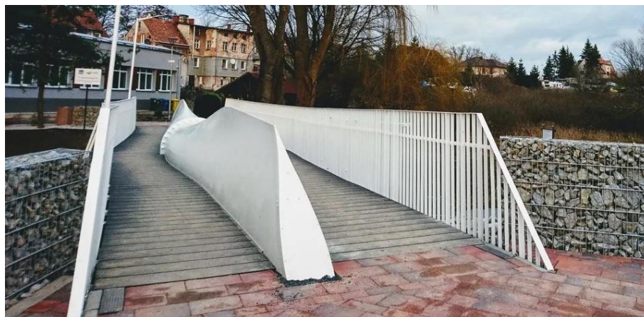
Figura 4.21 Primo ponte pedonale costruito da pale eoliche (Polonia)
