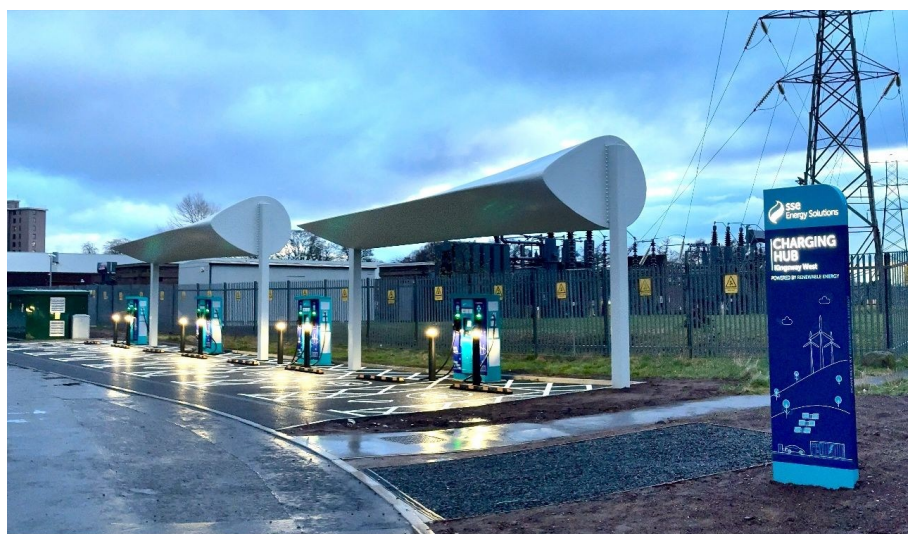
Figura 4.13 Realizzazione tettoia per la ricarica di macchine elettriche (Regno Unito)
