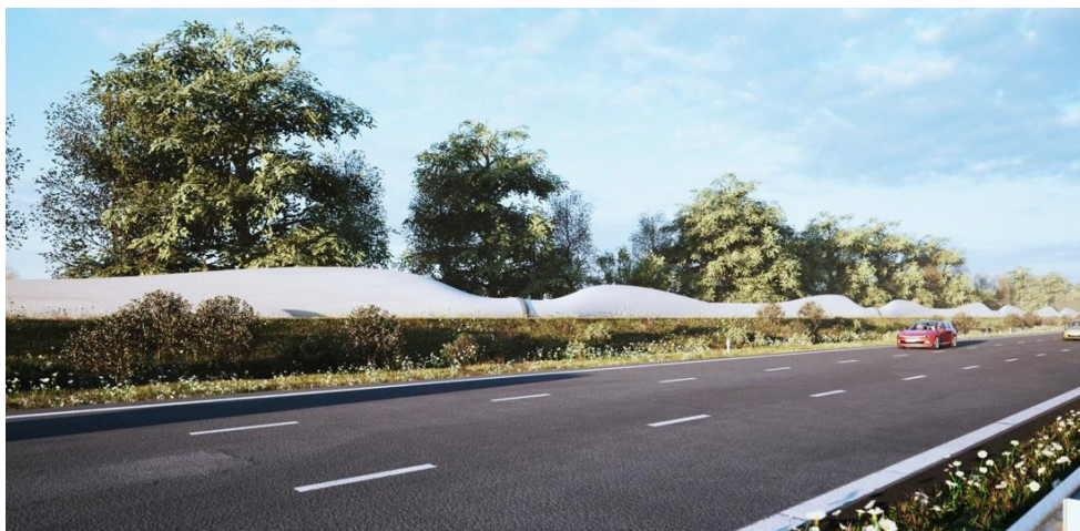
Figura 4.25 Installazione definitiva della barriera antirumore presso il sito InnovA58, Oirschot (Paesi Bassi)
