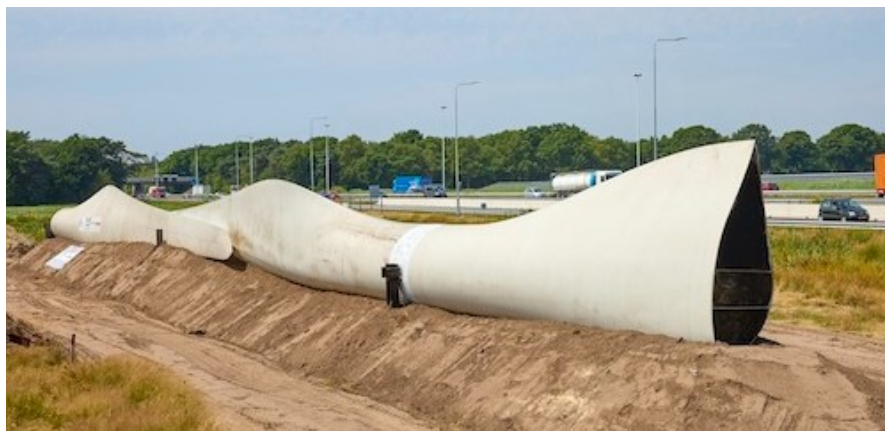
Figura 4.24 Installazione sperimentale della barriera antirumore presso il sito InnovA58, Oirschot (Paesi Bassi)
