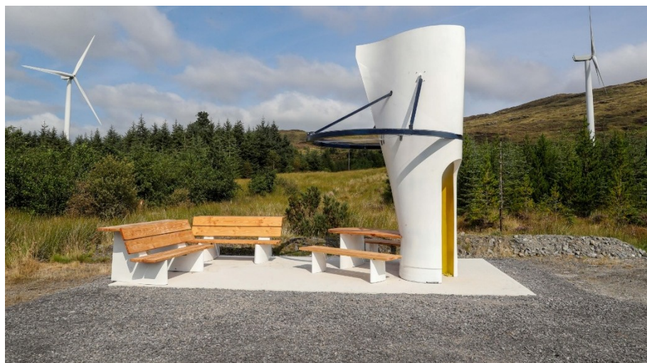
Figura 4.19 Pala eolica utilizzata per realizzare una tettoia situata all'interno del parco eolico di Meenadreen (Irlanda)
