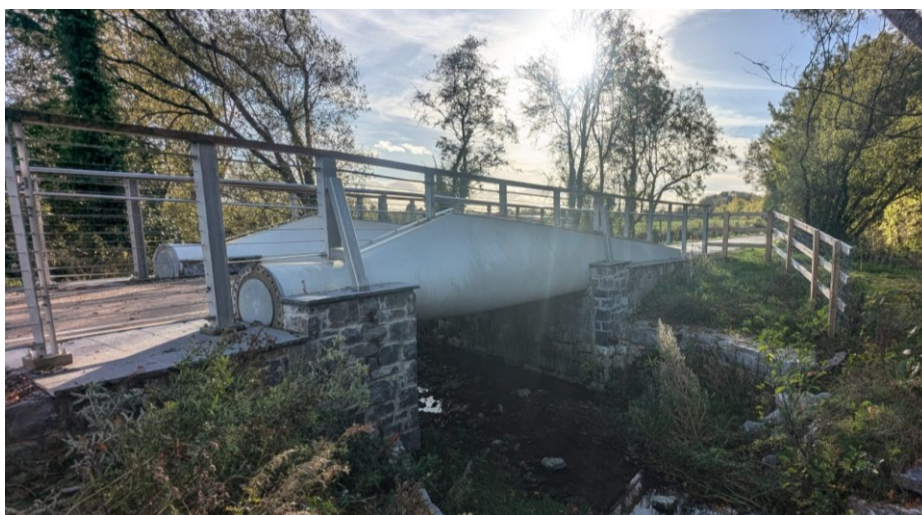
Figura 4.23 Secondo ponte pedonale costruito da pale eoliche (Irlanda)
