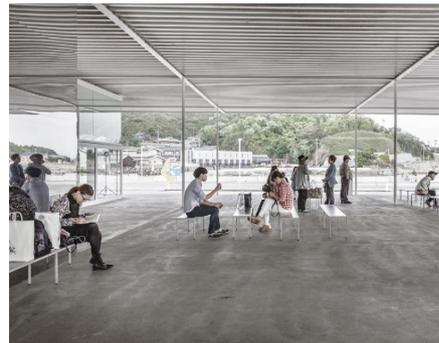
in acciaio, un rettangolo di 70 metri di lunghezza e 52 metri di larghezza, si appoggia su una griglia ortogonale di sottili colonne tubolari del diametro di 85 millimetri, che sopportano i carichi verticali. I carichi orizzontali sono invece gestiti da otto pannelli strutturali in acciaio con finitura a specchio, disposti in modo apparentemente casuale sulla pianta dell'edificio.
