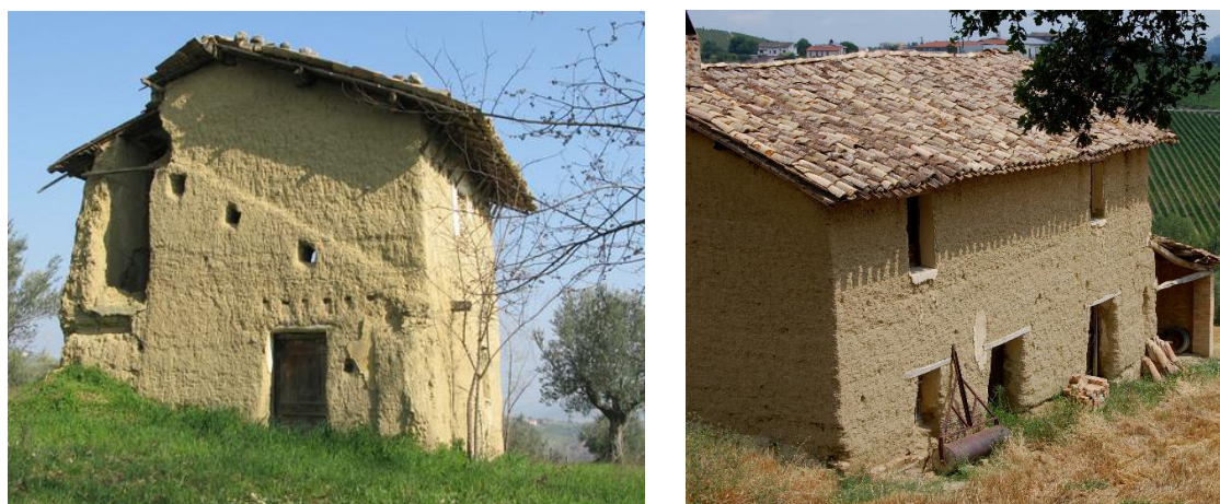
Figura 9) alcuni esempi di edifici caratterizzati da muratura in terra cruda.
