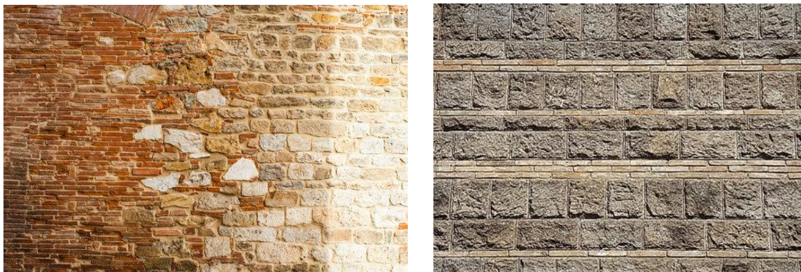
Figura 8) diversi tipi di murature miste in pietra e mattoni pieni.
