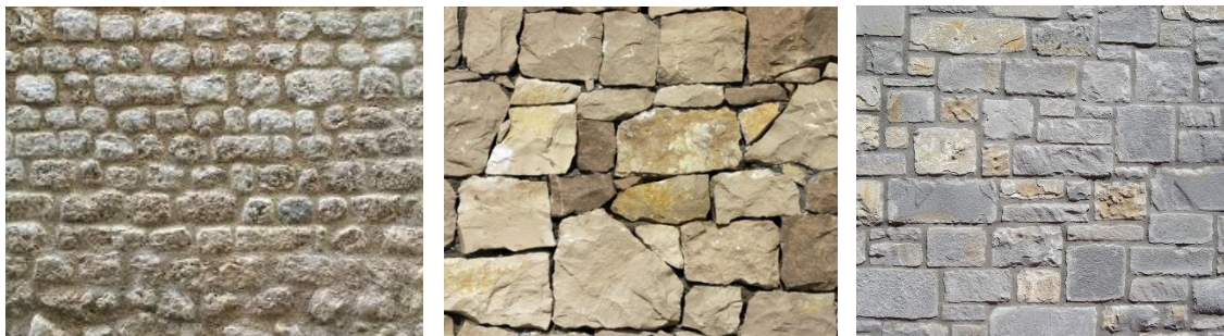
Figura 5) diversi tipi di murature in pietra. Rispettivamente muratura a conci sbazzati a sinistra, muratura in pietra a spacco al centro e muratura in blocchi lapidei squadrati a destra.
